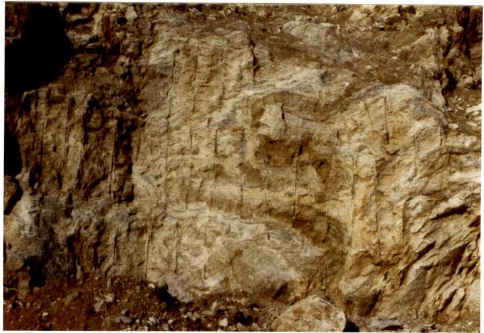
Fotografía 21.- Repliegue en los yesos con alguna intercalación arcillosa de la cantera, en el Km. 97.800 de la Carretera Alcaudete-Martos.
